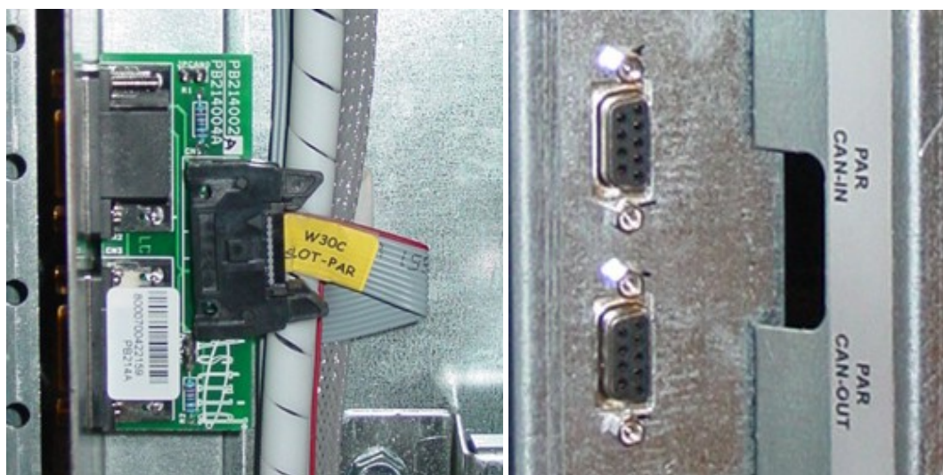
Figura 20 – Installazione scheda e connessione cavo flat
